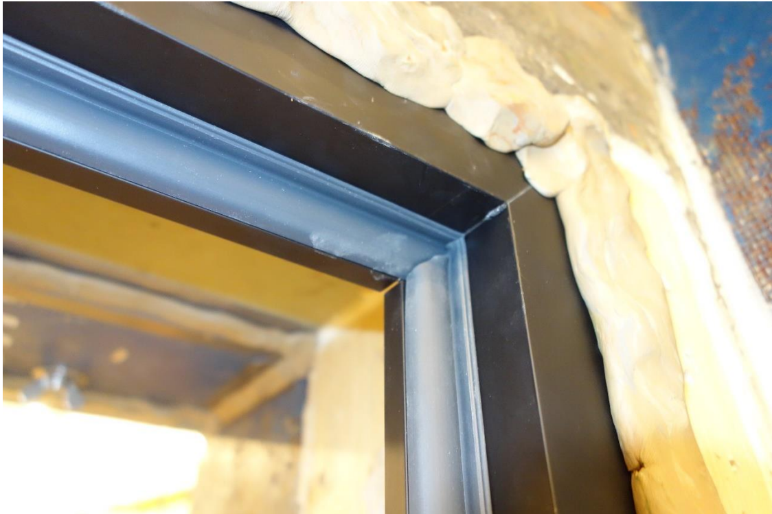
Bild 3 – Dörren vid mätningen i bilaga 1, karmen. Anslagsgummi 3 på karm.
