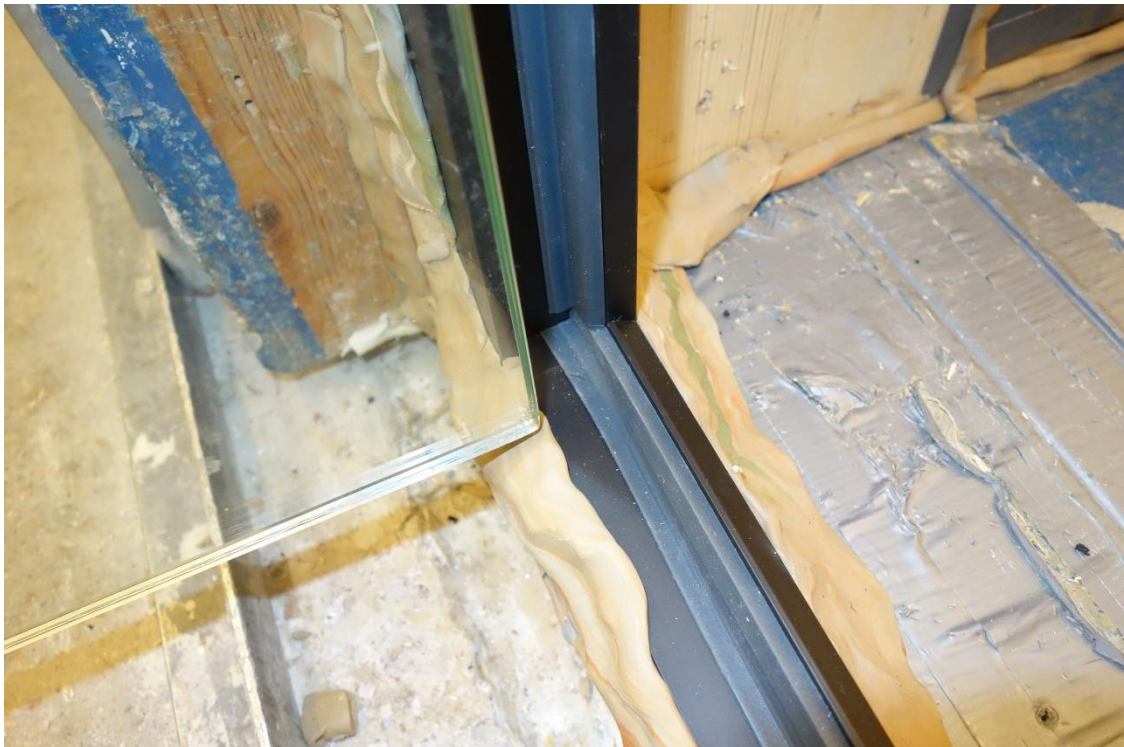
Bild 2 – Dörren vid mätningen i bilaga 1, ena nedre hörnet. Anslagsgummi 3 på karm och 2 på tröskel.
