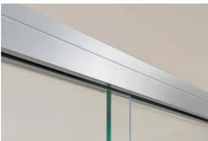
Internt syn på profil med længderille.
